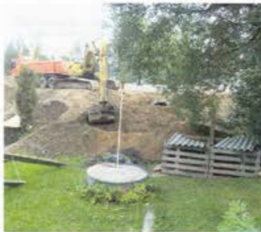
Mattilan talon kohdalla tie kulkee korkealla penkereellä. Tontin ranta-kaistale on penkereen takana.
